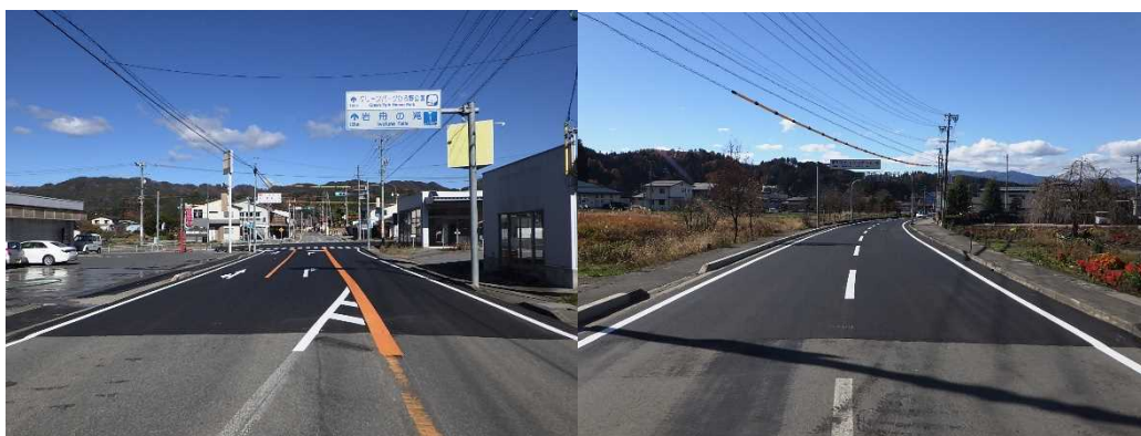
県単舗装道補修（暮らしの安全・安心確保対策）
