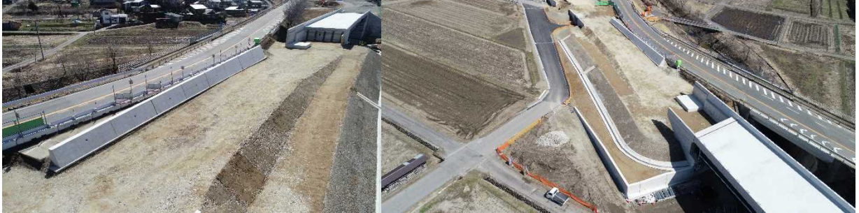
41号石浦バイパス道路建設工事
