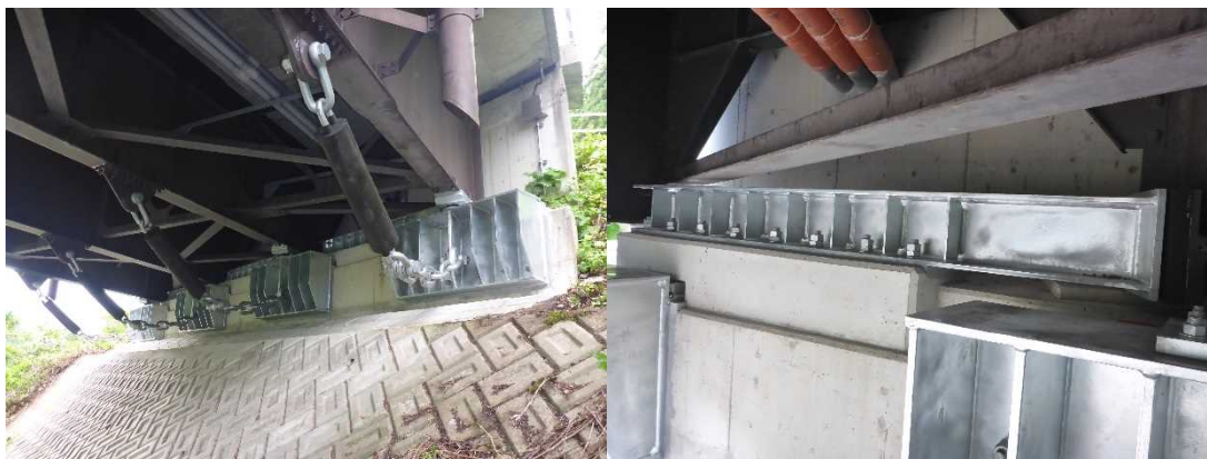
県単橋りょう維持修繕（暮らしの安全・安心確保対策）
