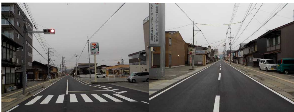
市道花岡冬頭線舗装繕工事
