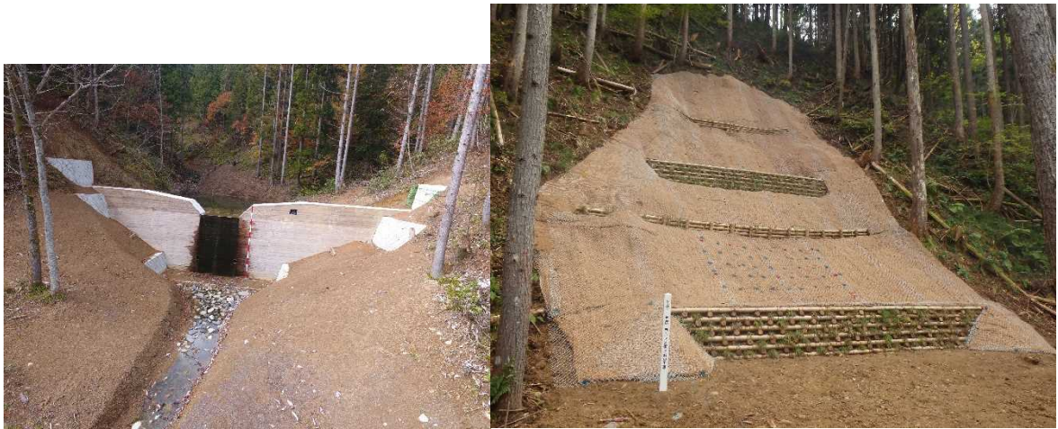
西ウレ2復旧治山工事
