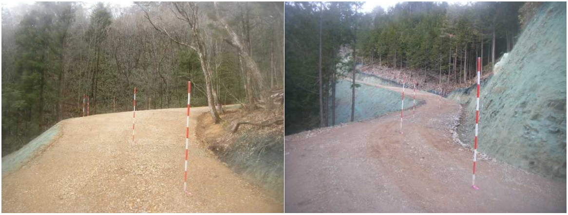
一ノ谷線 4号作業業開設工事
