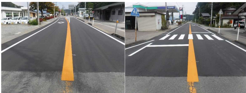
県単舗装道補修（清見三日町）
