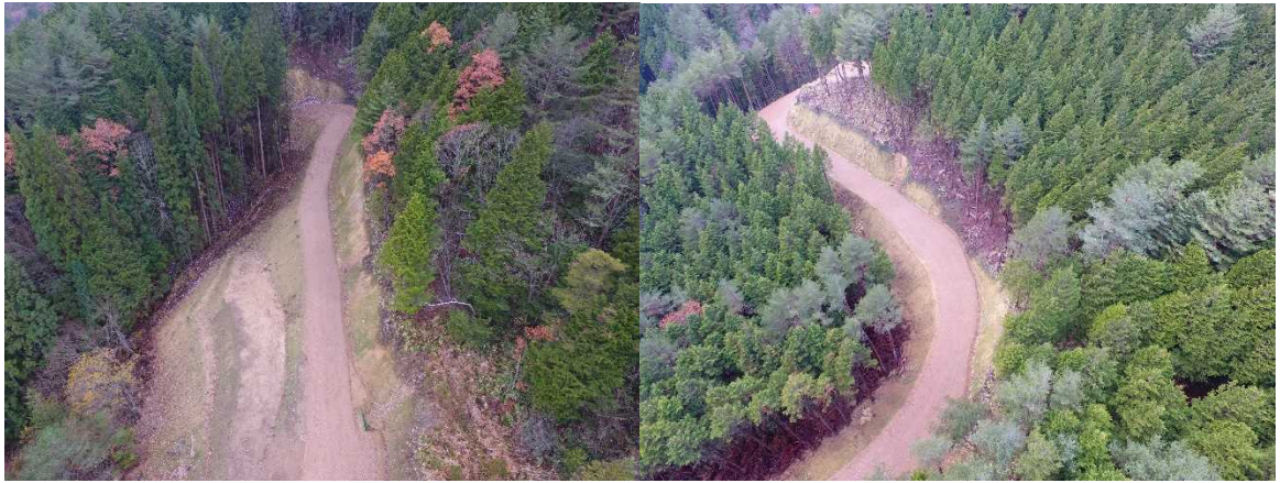
一ノ谷線 2, 3号作業業開設工事
