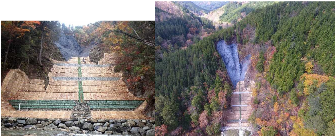
宮（大ヌクキ谷）復旧治山工事
