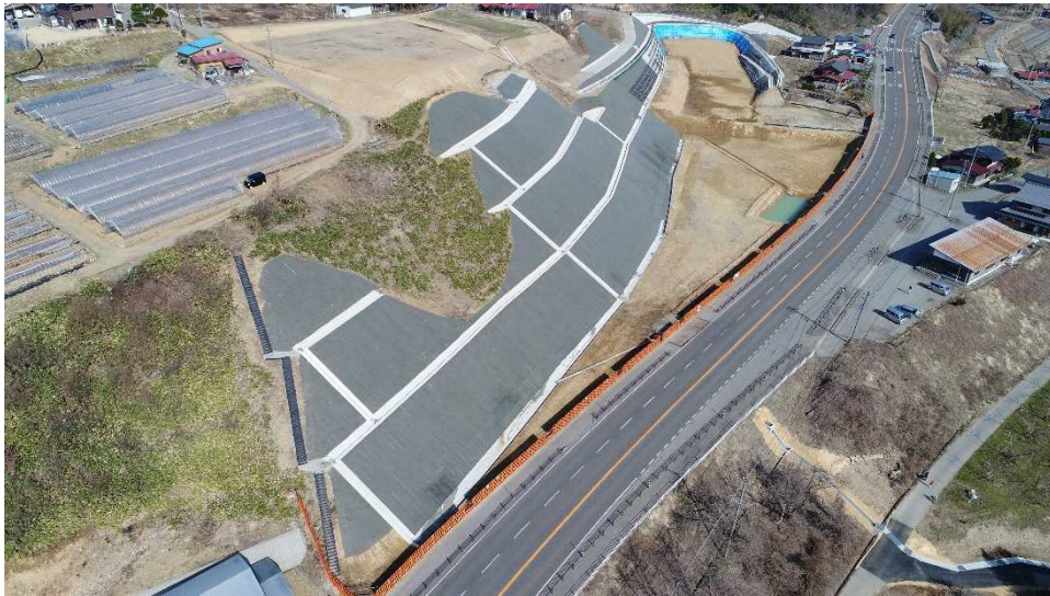
久々野道路建設工事
